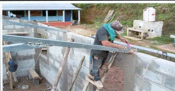
Foto: 5 MEJORAMIENTO MODULO DE AULA TIPO PORTICO, MONTAJE DE ESTRUCTURA PARA TECHO
