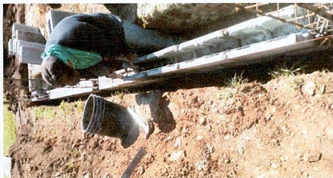
Foto: 1 MEJORAMIENTO MODULO DE AULA TIPO PORTICO, FUNDICION DE CIMENTO CORRIDO ENCOFRADO Y DESENCOFRADO
