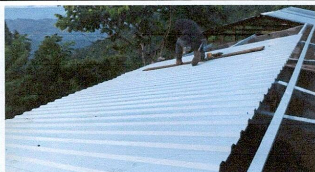
Foto: 6 MEJORAMIENTO MODULO DE AULA TIPO PORTICO, COLOCACIÓN DE LÁMINA TROQUELADA CALIBRE 26
