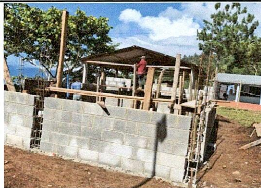
Foto: 2 MEJORAMIENTO MODULO DE AULA TIPO PORTICO, LEVANTADO DE BLOCK Y FUNDICIÓN DE COLUMNAS
